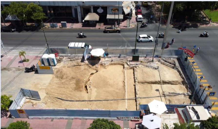
Εργοταξιακή περίφραξη - Φρέαρ «Βιβλιοθήκη».
