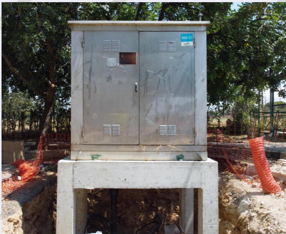
Μεταφορά υποσταθμού φυσικού αερίου στο Φρέαρ TBM Βεΐκου.
