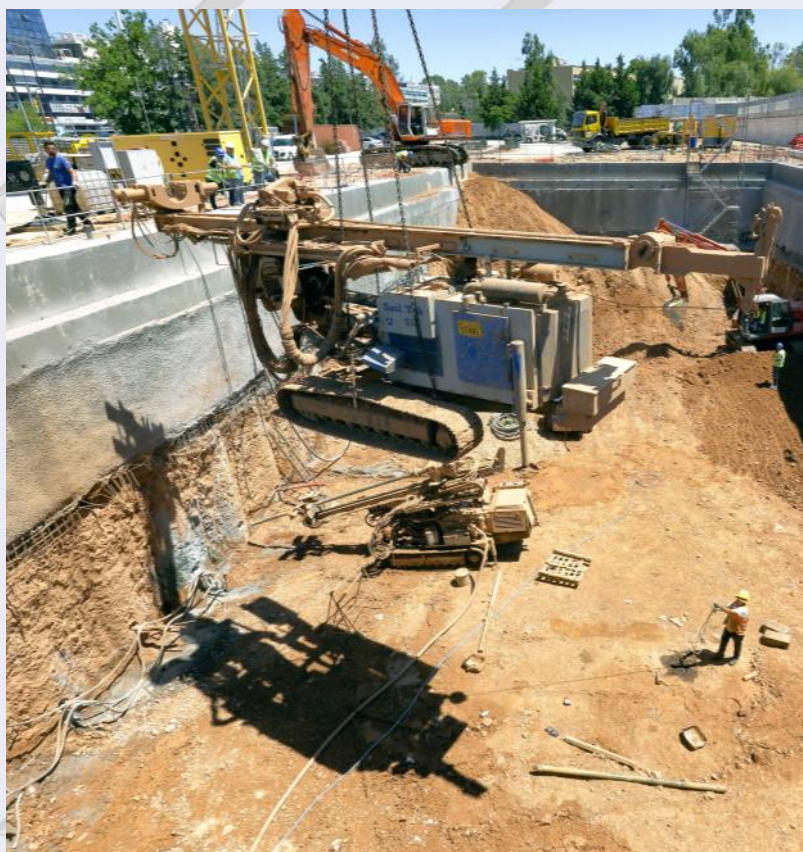
Εισκόμηση διατρητικού εξοπλισμού κατασκευής αγκυρίων στο Φρέαρ ΤΒΜ Κατεχάκη.
