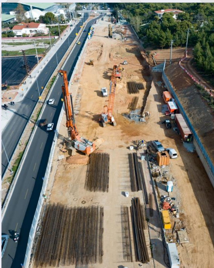
Διάτρηση πασσάλων στο Φρέαρ TBM Βείκου.
