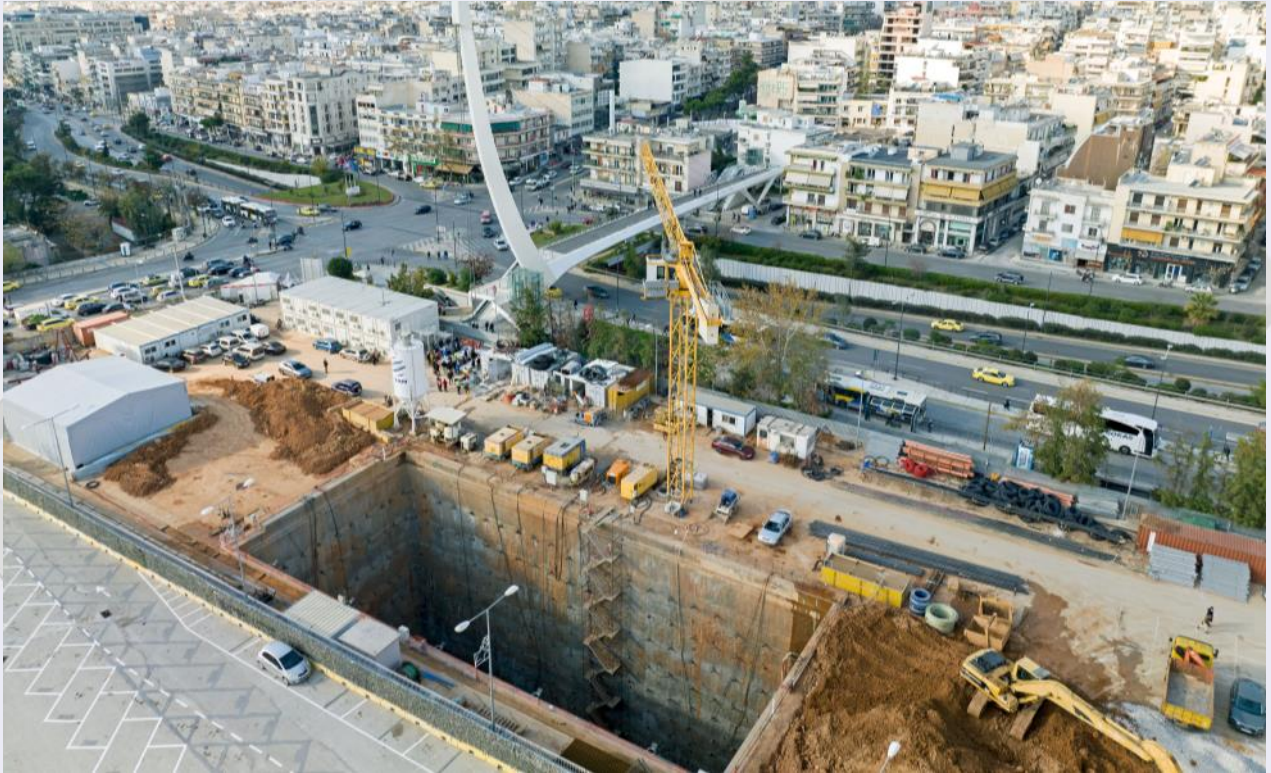
Φρέαρ TBM Κατεχάκη.
