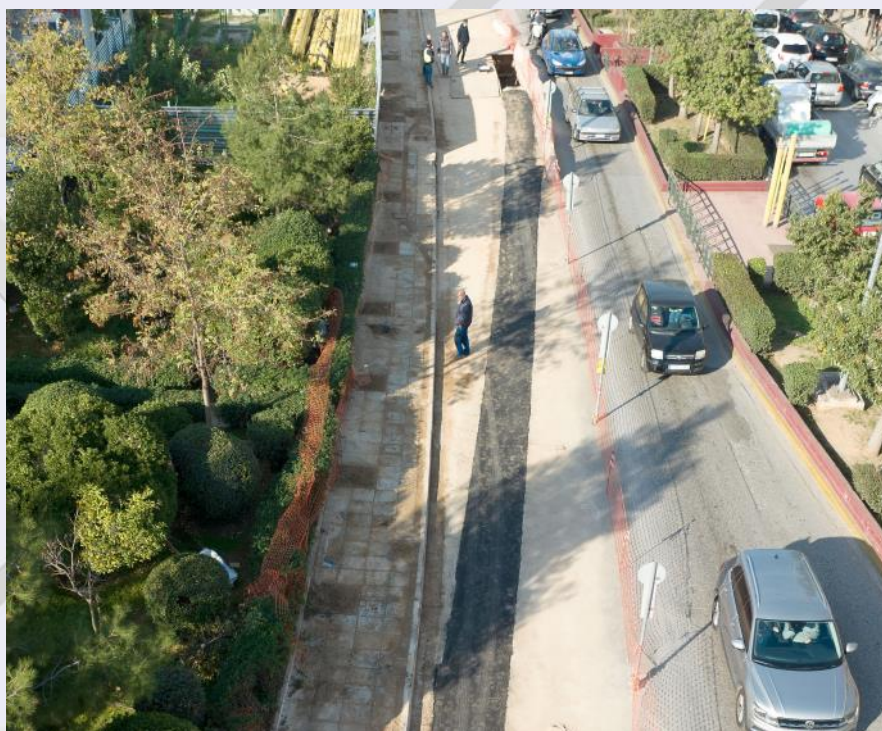
Αποκαταστάσεις πεζοδρομίων στον Στ. «Γαλάτσι».
