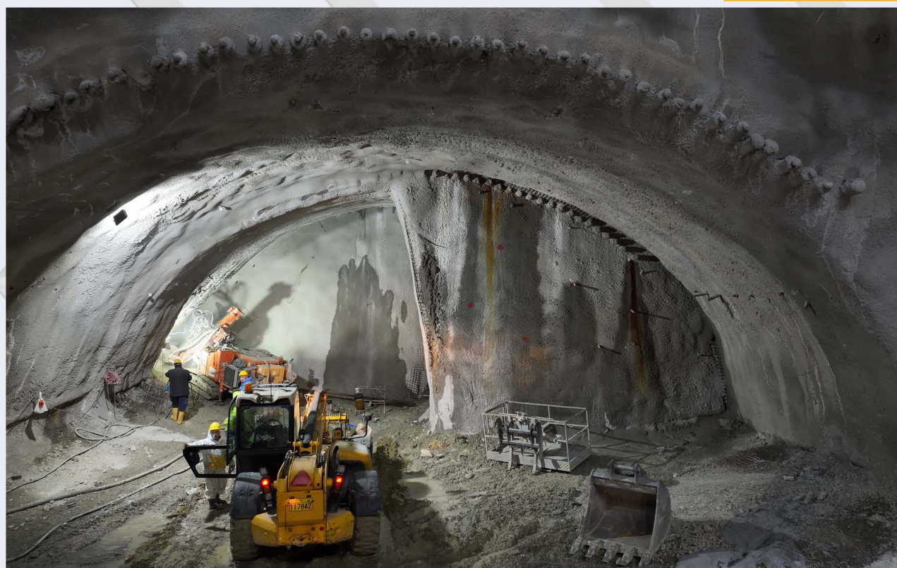
Εκσκαφή σήραγγας NATM στον Σταθμό «Δικαστήρια».
