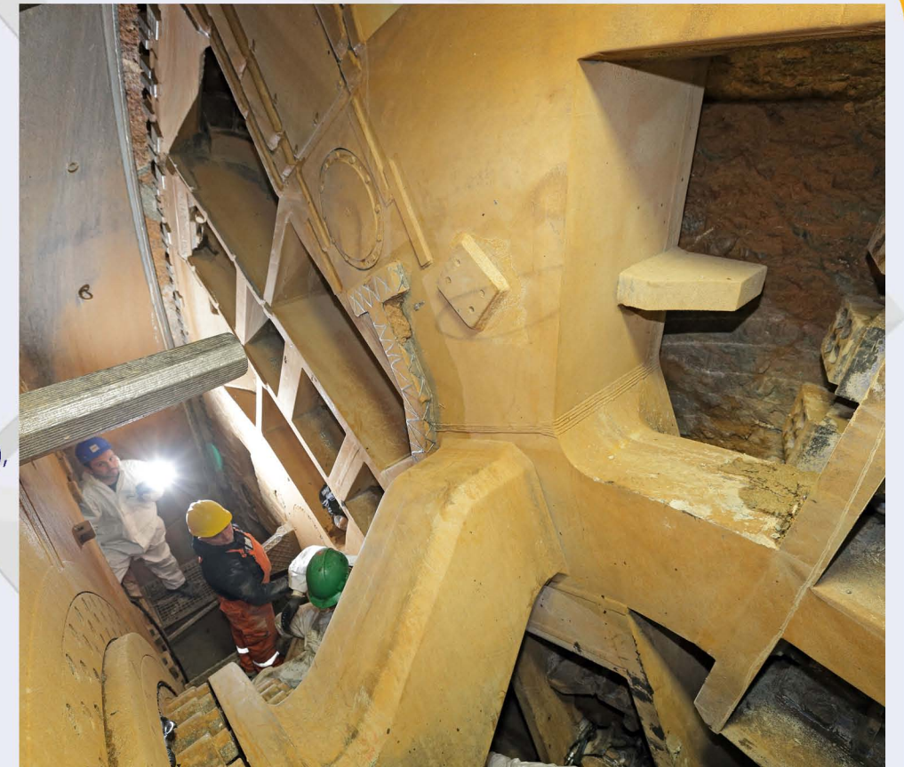
Εργασίες συντήρησης εντός του θαλάμου εκσκαφής του TBM «ΑΘΗΝΑ».
