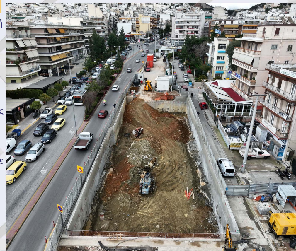
Κεντρικό όρυγμα του Σταθμού «Γαλάτσι».
