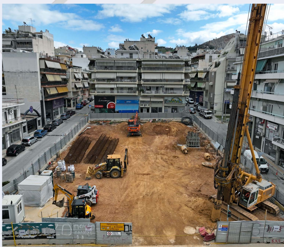
Κατασκευή πασσάλων στο κεντρικό όρυγμα του Σταθμού «Άλσος Βεΐκου».
