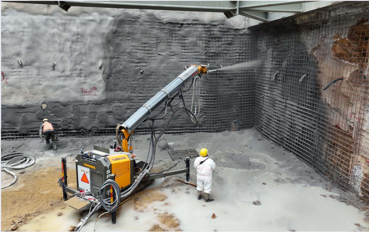
Ρίψη εκτοξευόμενου σκυροδέματος στο 8ο επίπεδο του Σταθμού «Ακαδημία».
