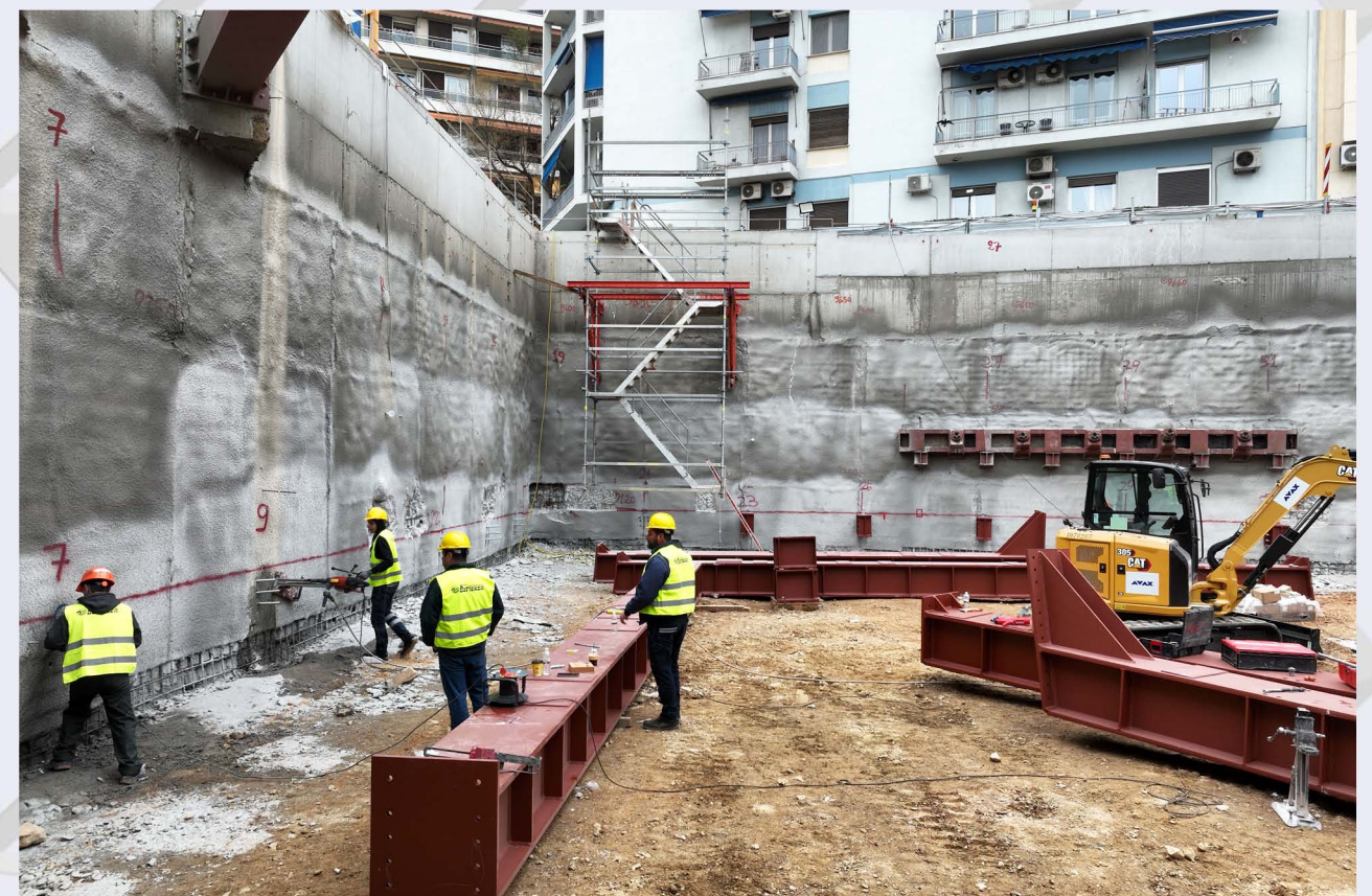
Διαδικασία εγκατάστασης αντηρίδας - Φρέαρ ΔΙΑΚΛΑΔΩΣΗΣ ΕΥΑΓΓΕΛΙΣΜΟΥ.
