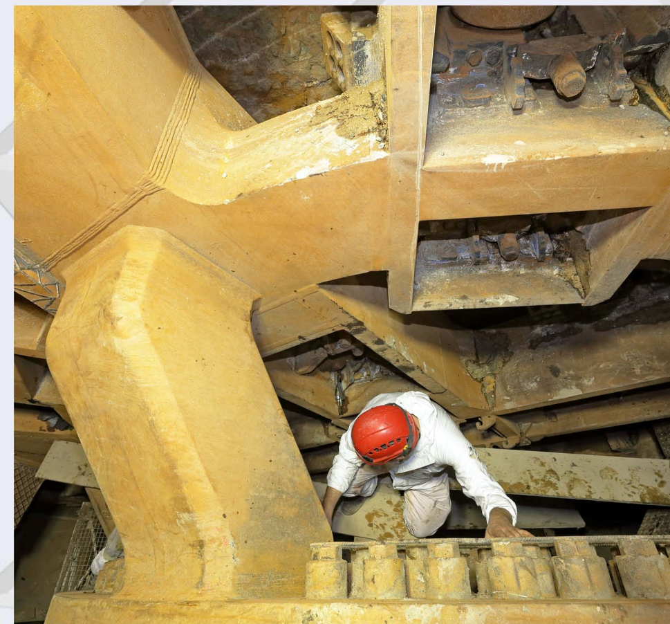
Εργασίες συντήρησης εντός του θαλάμου εκσκαφής του TBM «ΑΘΗΝΑ».
