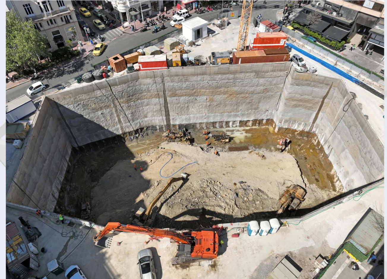
Διάτρηση αγκυρίων 3ου επιπέδου στον Στ. «Κολωνάκι».
