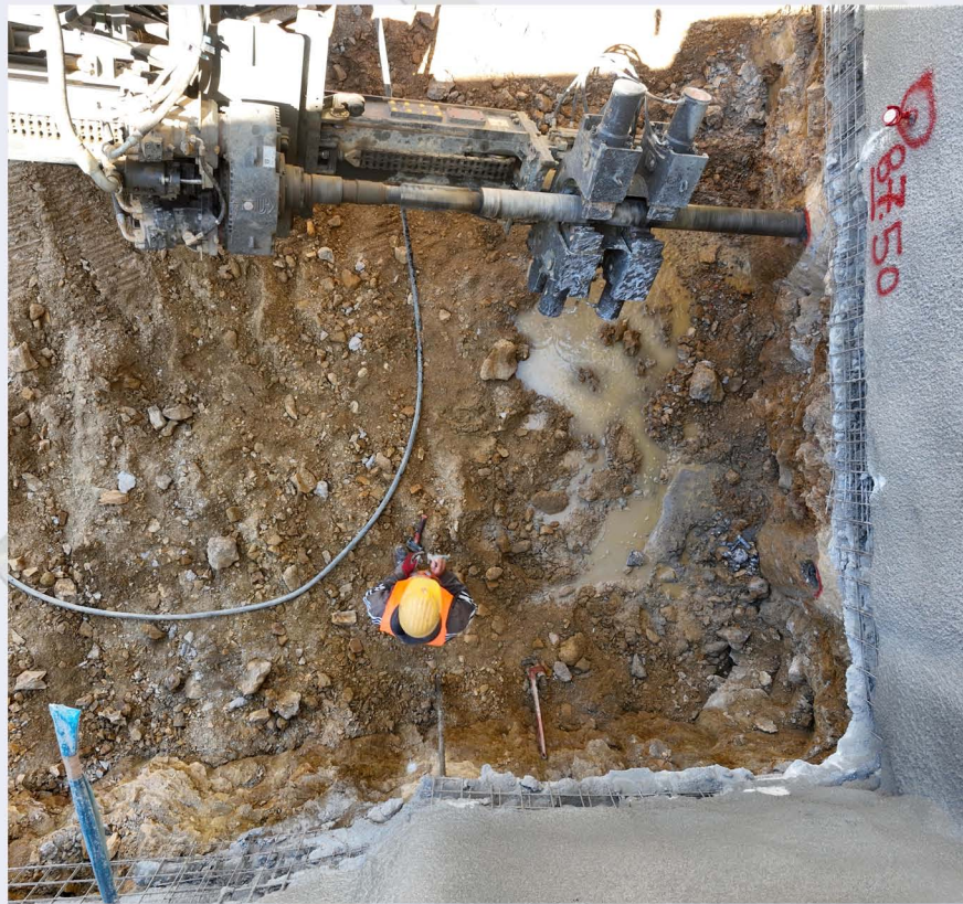
Διάτρηση αγκυρίων - Σταθμός «Ακαδημία».
