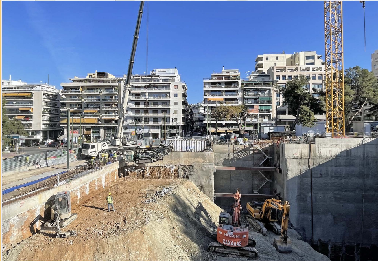
Διάτρηση αγκυρίων και εκσκαφή στον Στ. «Δικαστήρια».
