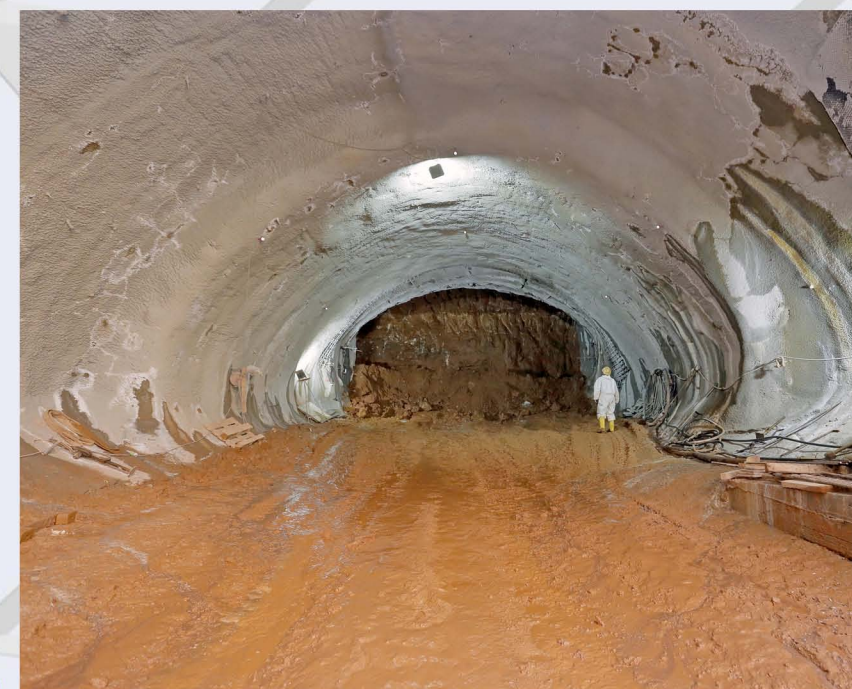
Εκσκαφή συνδετήριας σήραγγας - Φρέαρ ΓΝΑ.
