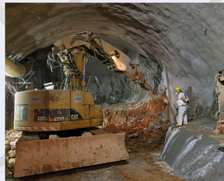
Εκσκαφή θαλάμου πρόσβασης - Φρέαρ ΓΝΑ.
