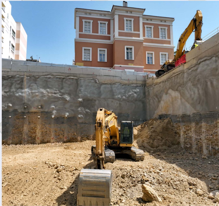
Εκσκαφή κεντρικού ορύγματος - Σταθμός «Ακαδημία».
