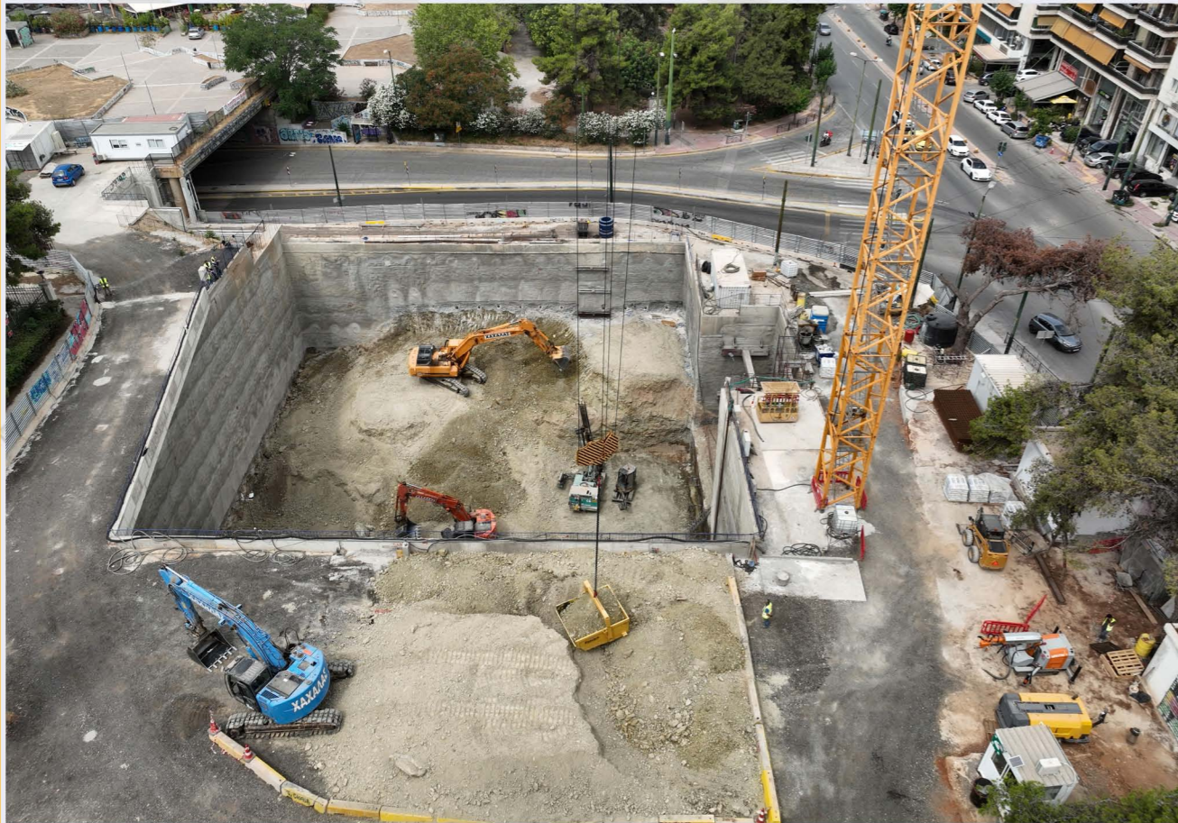
Διάτρηση αγκυρίων και εκσκαφή στον Στ. «Δικαστήρια».
