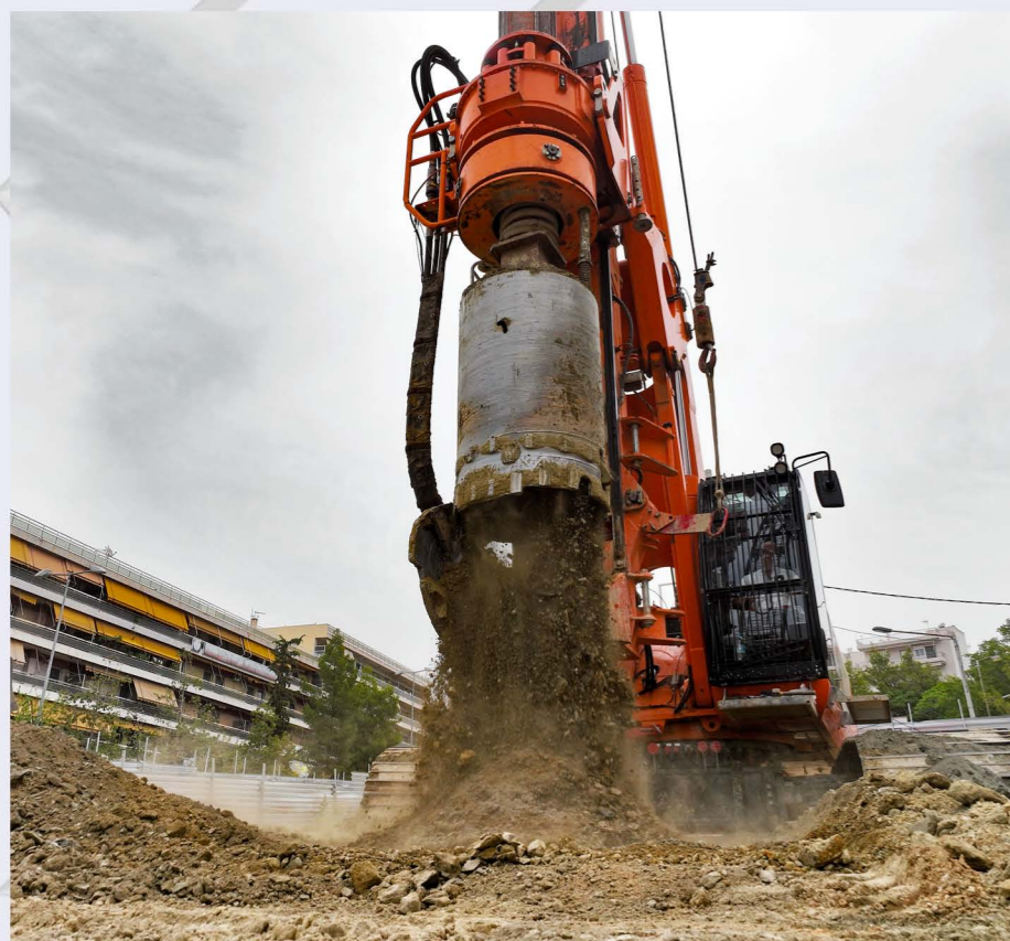
Διάτρηση πασσάλων - Σταθμός «Γαλάτσι».
