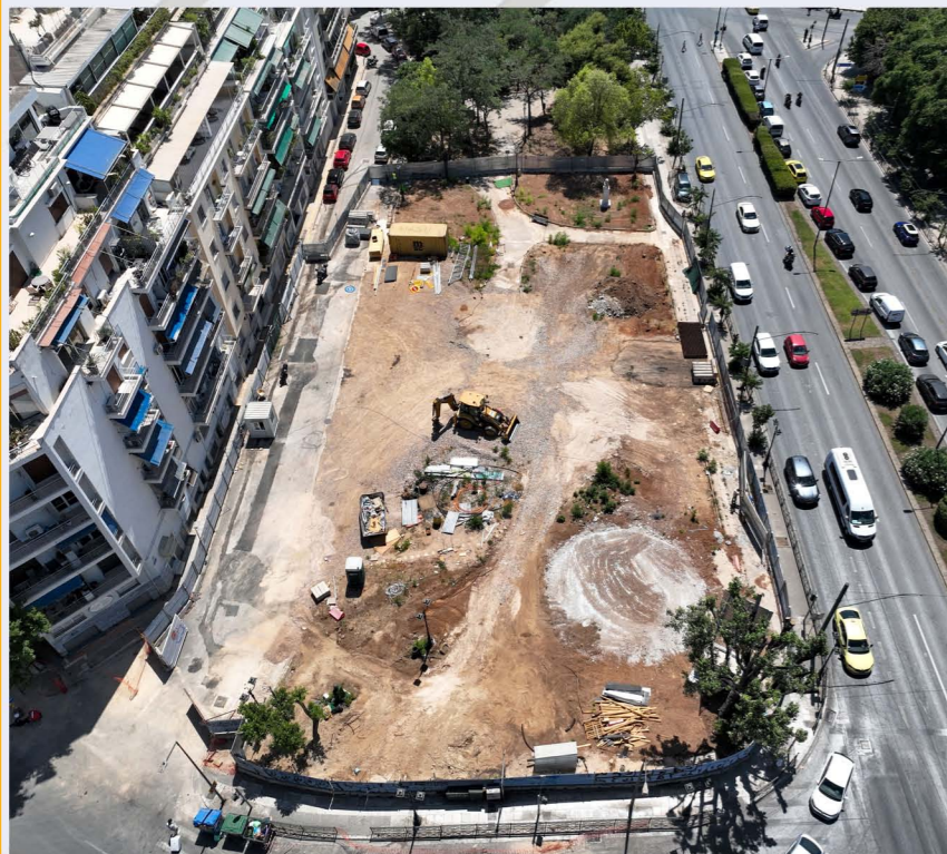
Προπαρασκευαστικές εργασίες στο Φρέαρ Διακλάδωσης Ευαγγελισμού.
