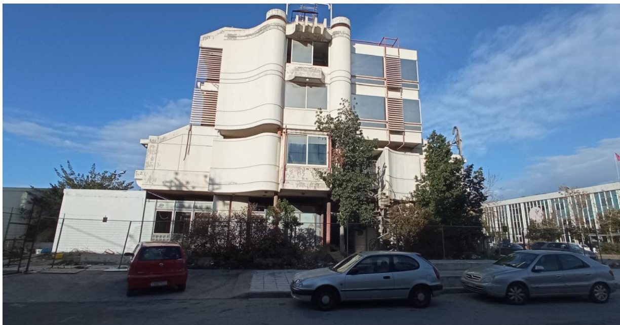
Φωτο.1 Ανατολική άποψη του κτιρίου 1, ιδιοκτησία Α
