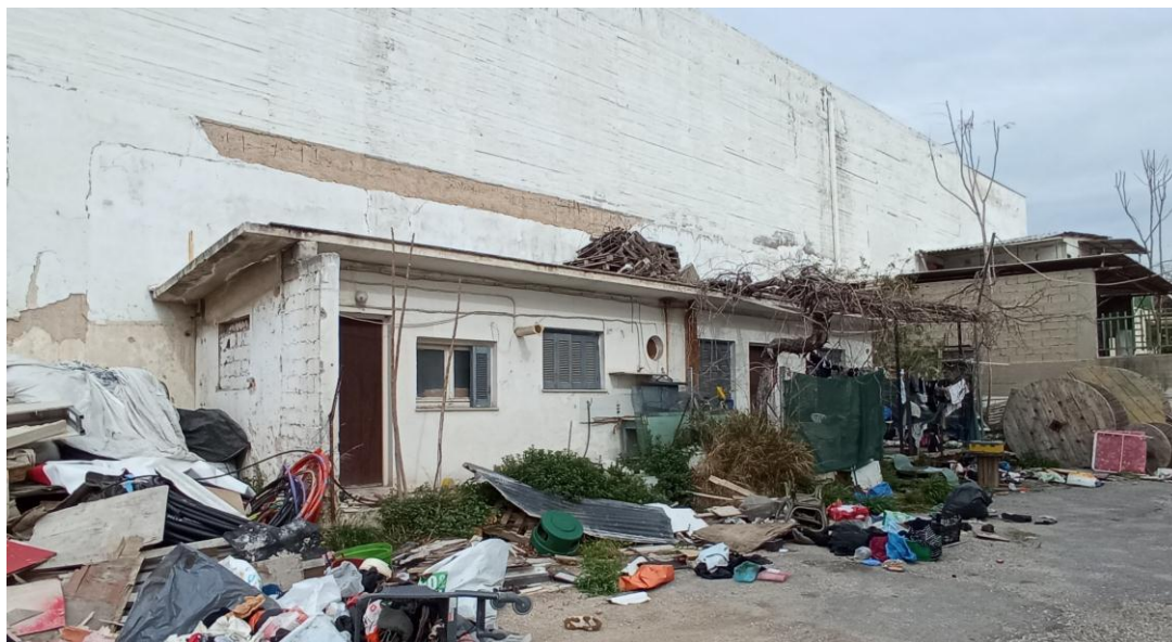
Φωτο. 7 Το βοηθητικό κτίσμα στο δυτικό όριο της ιδιοκτησίας Δ
