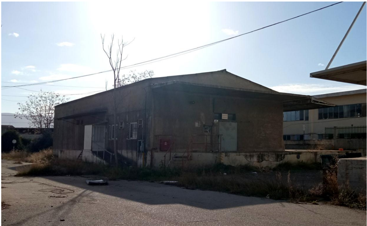
Φωτο.3 Βορειοδυτική άποψη του κτιρίου 3, ιδιοκτησίας Γ
