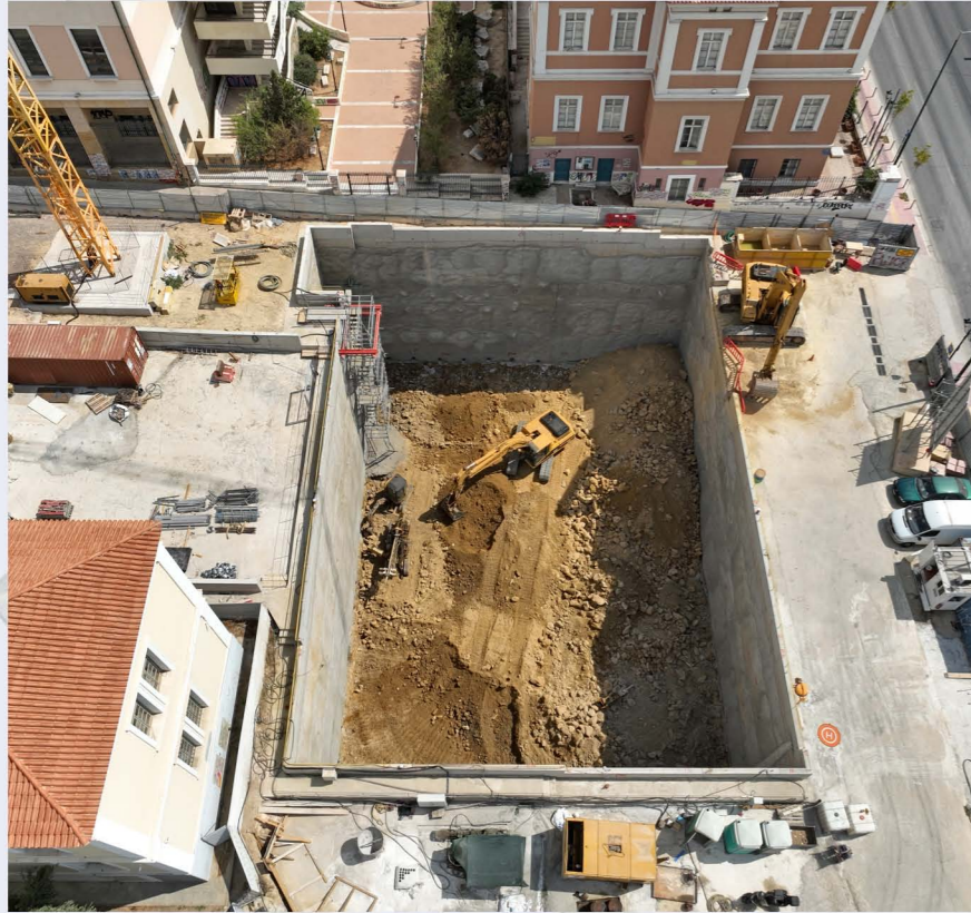
Εκσκαφή κεντρικού ορύγματος - Σταθμός «Ακαδημία».
