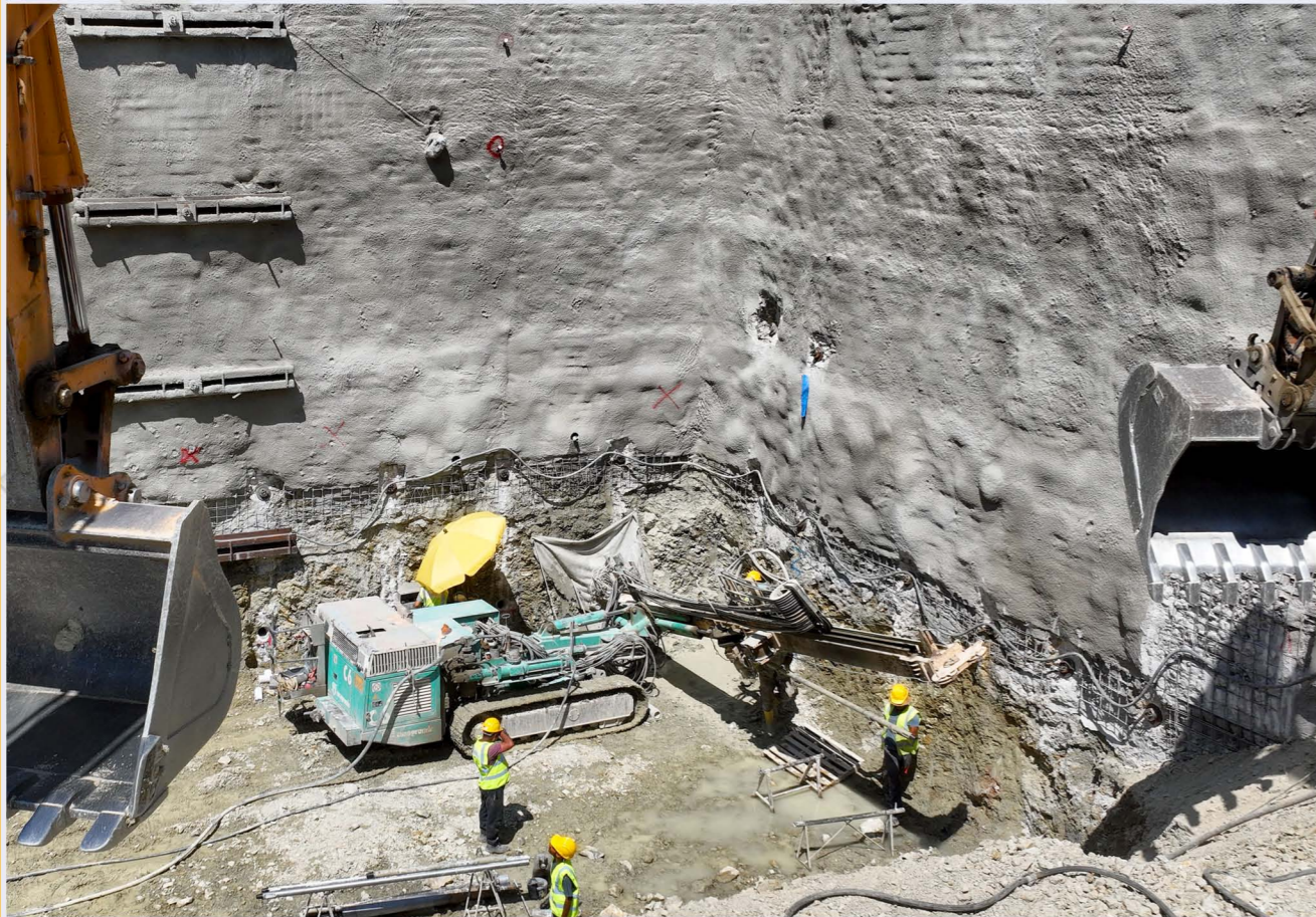
Διάτρηση αγκυρίων και εκσκαφή στον Στ. «Δικαστήρια».
