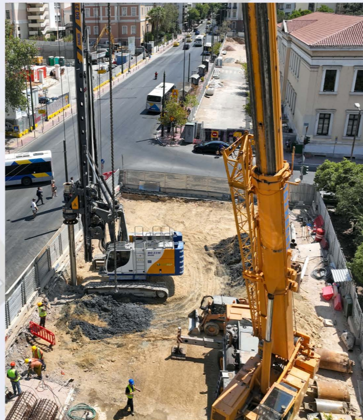
Διάτρηση πασσάλων - Φρέαρ ΒΙΒΛΙΟΘΗΚΗ.
