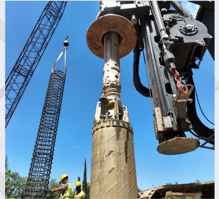
Διάτρηση πασσάλων - Φρέαρ Διακλάδωσης Ευαγγελισμού.
