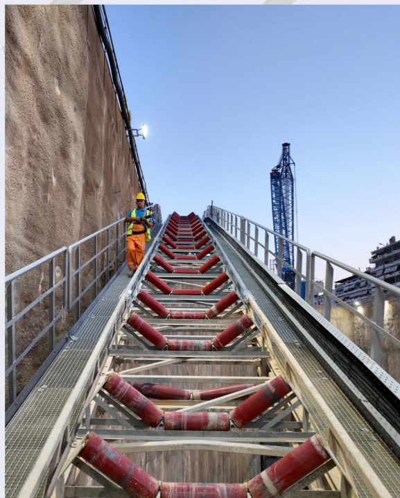
Συναρμολόγηση μεταφορικής ταινίας στο Φρέαρ TBM Βεΐκου.
