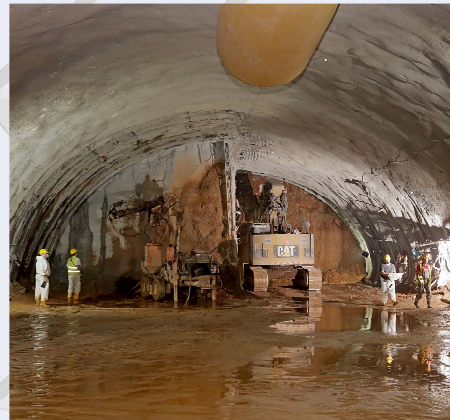
Συνδετήρια σήραγγα - Φρέαρ ΓΝΑ.
