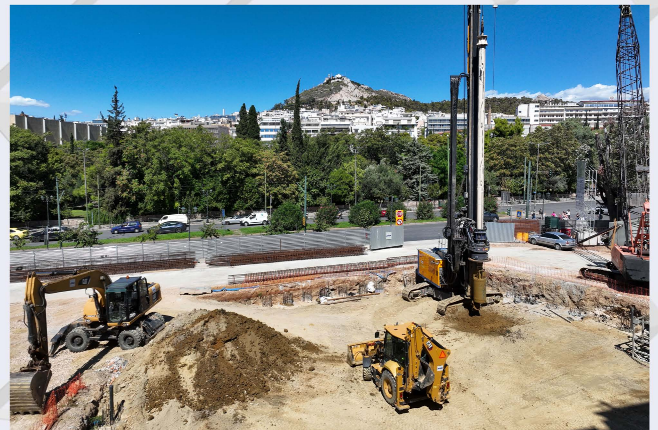
Κατασκευή πασσάλων - Φρέαρ ΔΙΑΚΛΑΔΩΣΗΣ ΕΥΑΓΓΕΛΙΣΜΟΥ.
