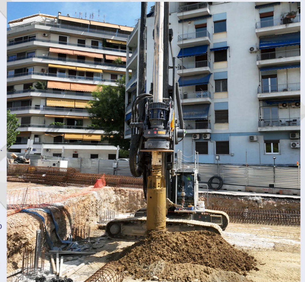
Διάτρηση πασσάλων - Φρέαρ ΔΙΑΚΛΑΔΩΣΗΣ ΕΥΑΓΓΕΛΙΣΜΟΥ.
