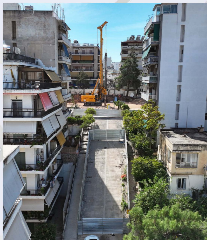
Διάτρηση πασσάλων - Σταθμός «Ιλίσια».
