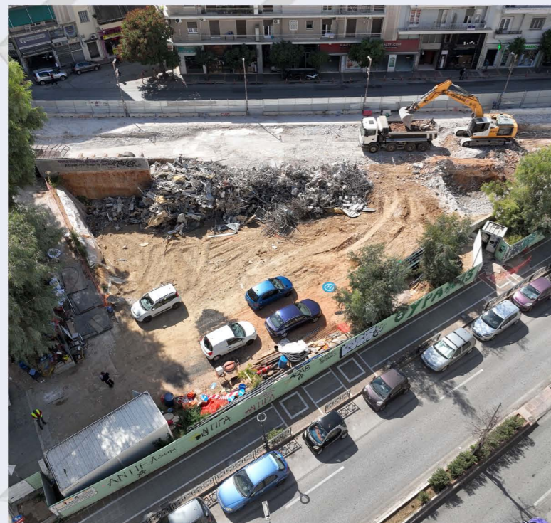
Καθαίρεση κτηρίου - Σταθμός «Ζωγράφου».
