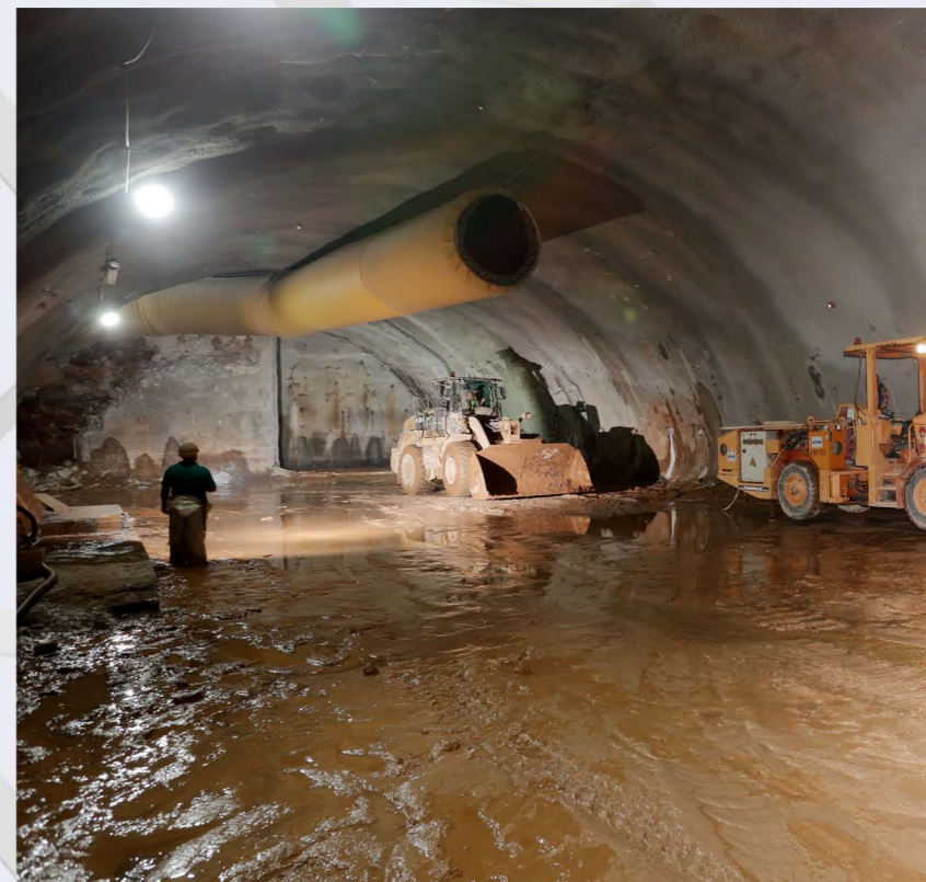
Σήραγγα Επιστάθμου - Φρέαρ ΓΝΑ.
