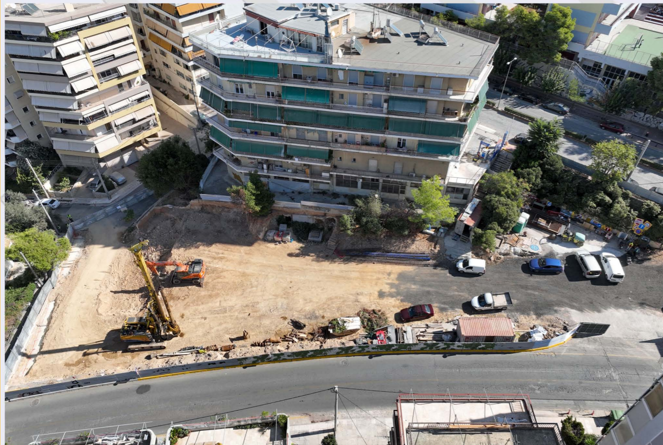
Άφιξη διατρητικού μηχανήματος στον Στ. «Ελικώνος».
