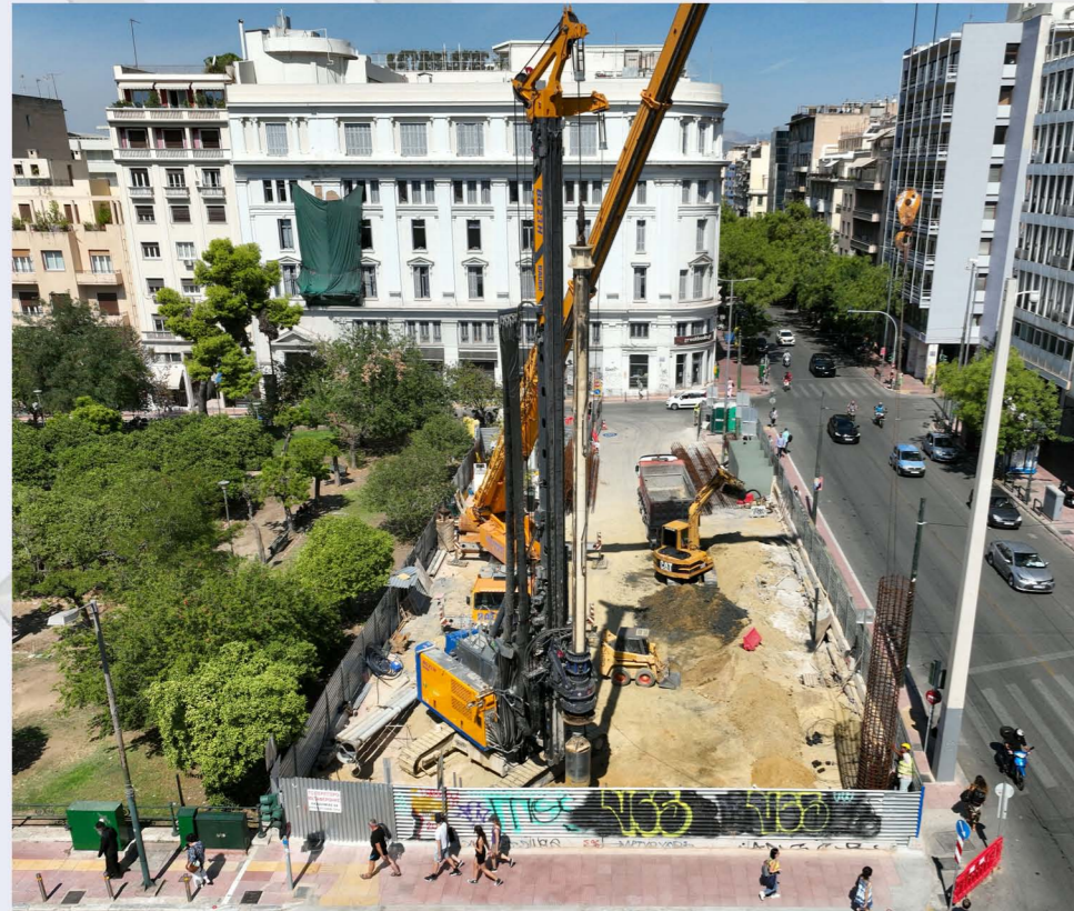
Κατασκευή πασσάλων - Φρέαρ ΒΙΒΛΙΟΘΗΚΗ.
