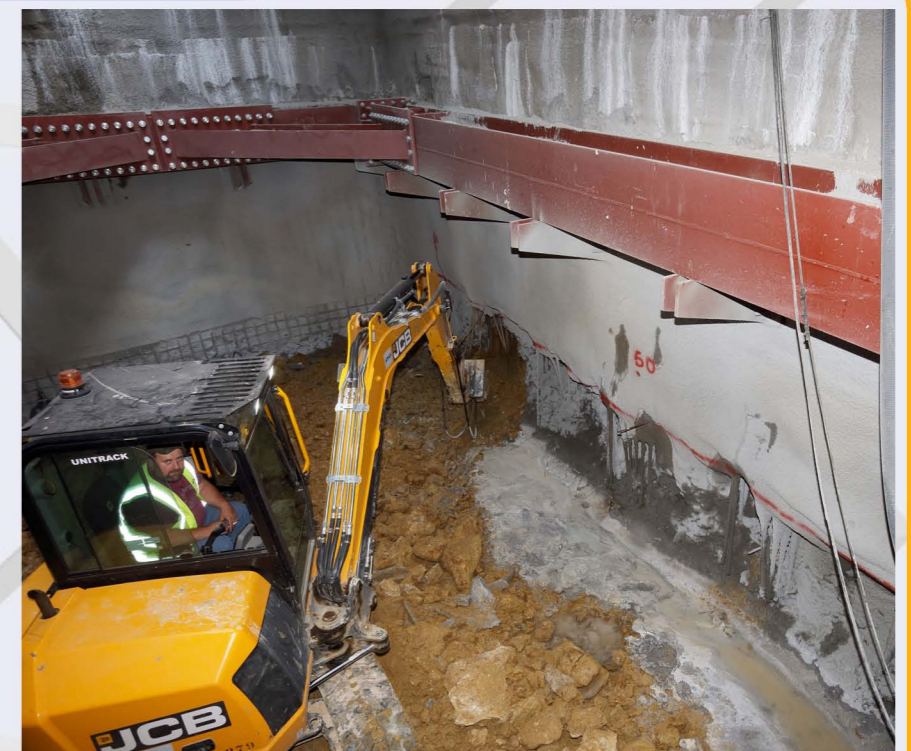
Εκσκαφή 5ου επιπέδου στο Φρέαρ ΕΥΔΑΠ.
