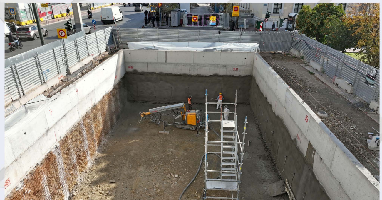
Εκσκαφή στο Φρέαρ ΒΙΒΛΙΟΘΗΚΗΣ.
