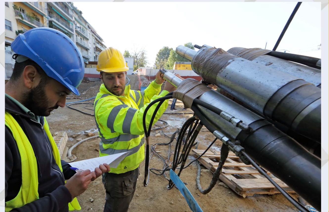
Διαδικασία τάνυσης αγκυρίων - Φρέαρ ΔΙΑΚΛΑΔΩΣΗΣ ΕΥΑΓΓΕΛΙΣΜΟΥ.
