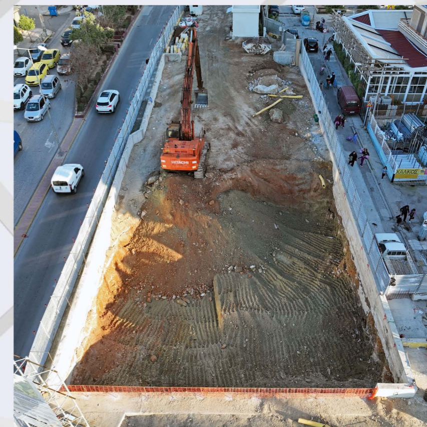
Κεντρικό όρυγμα του Σταθμού «Γαλάτσι».
