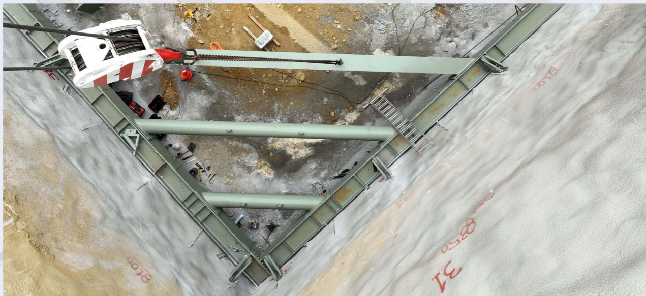
Εργασίες τοποθέτησης αντηρίδων στον Στ. «Ακαδημία».
