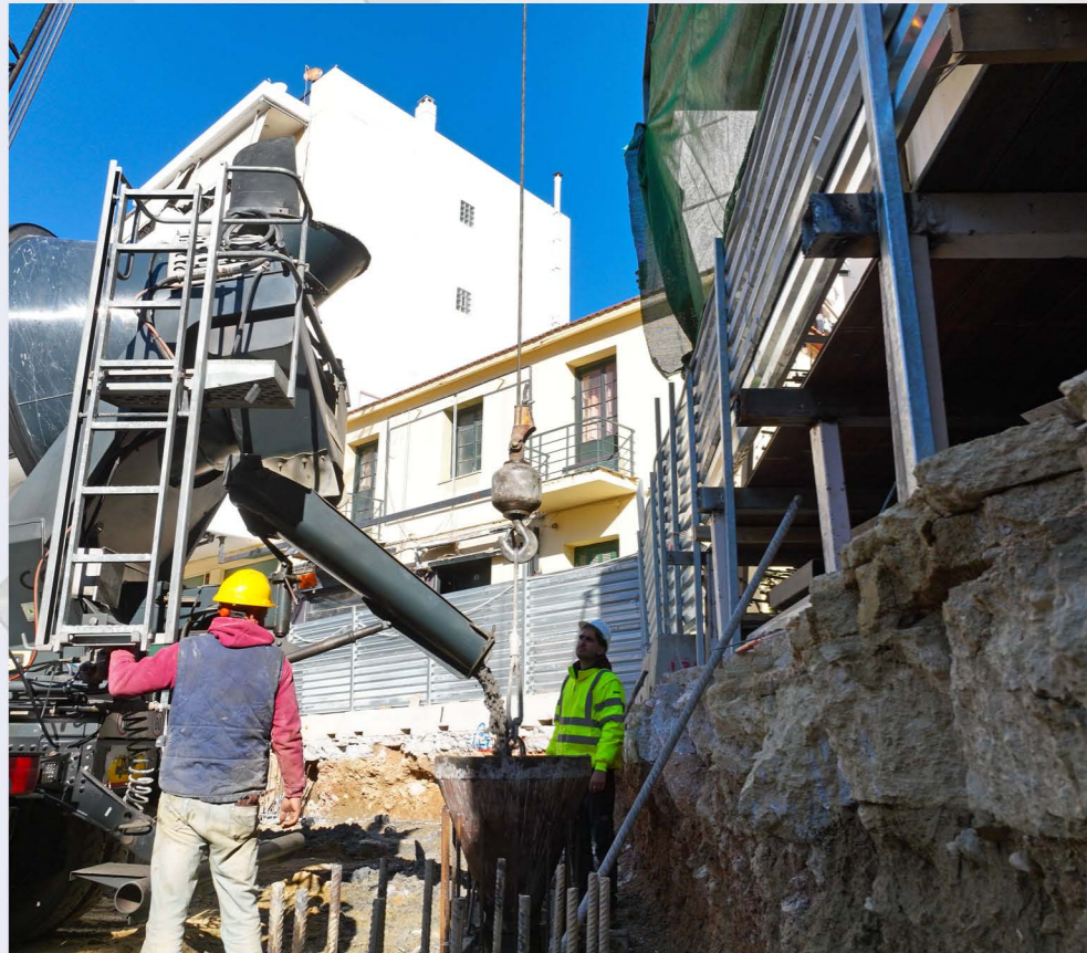
Σκυροδέτηση πασσάλων - Σταθμός «Καισαριανή».
