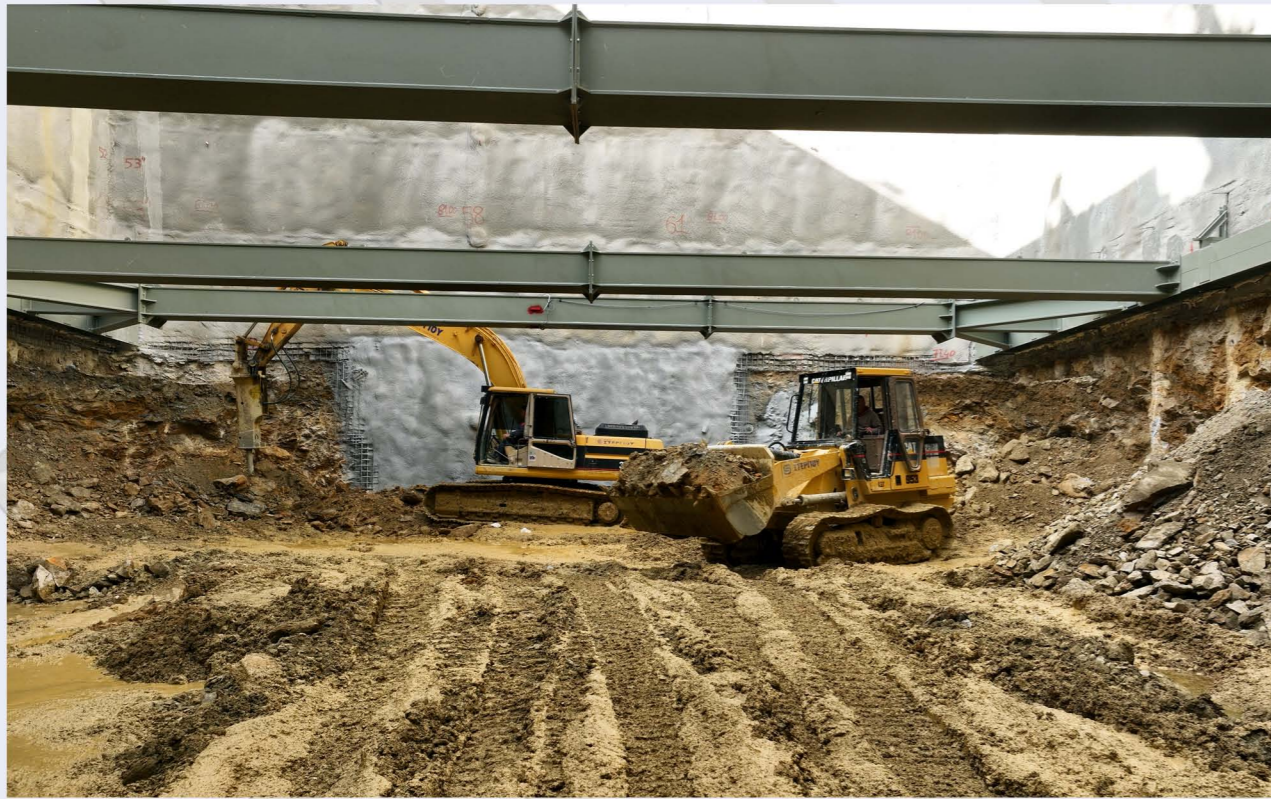
Εκσκαφή 7ου επιπέδου στον Σταθμό «Ακαδημία».
