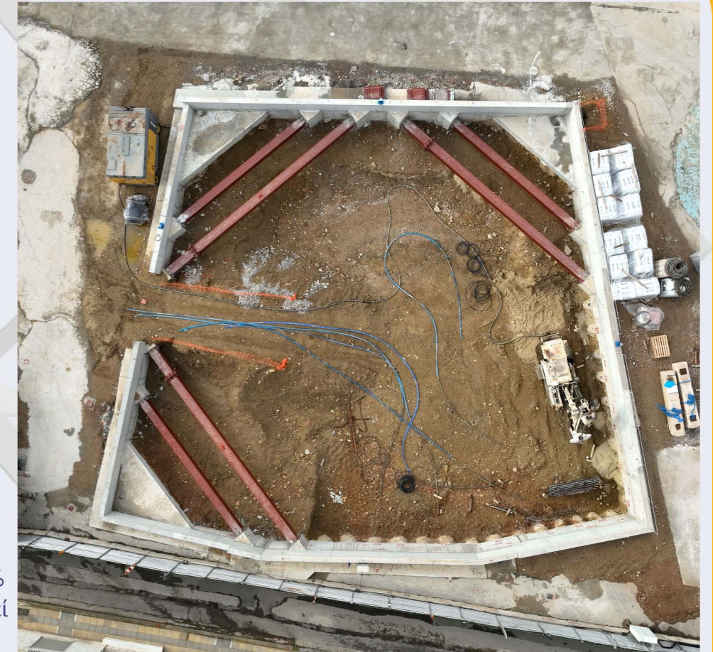
Φρέαρ ΔΙΑΚΛΑΔΩΣΗΣ ΕΥΑΓΓΕΛΙΣΜΟΥ.
