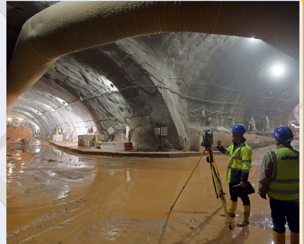
Σήραγγα Επιστάθμου - Φρέαρ ΓΝΑ.
