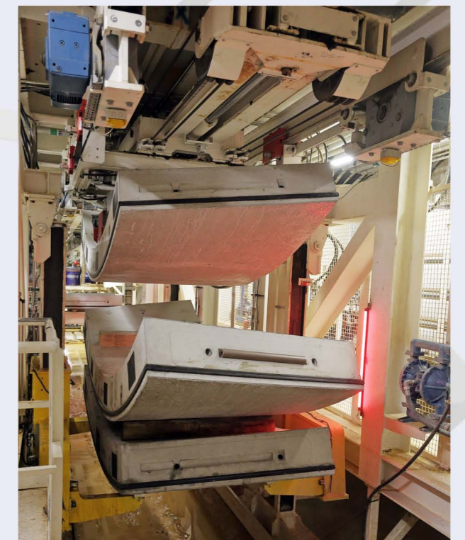
Μεταφορά προκατασκευασμένων δακτυλιδίων εντός του TBM.
