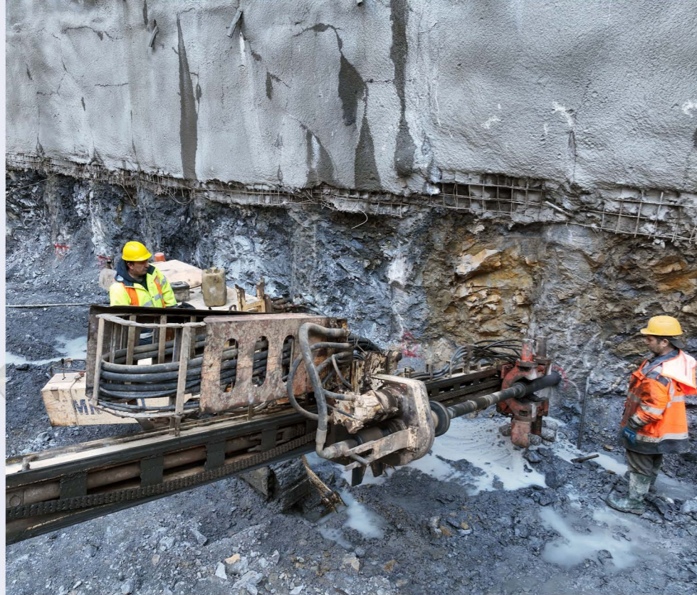
Διάτρηση αγκυρίων - Σταθμός «Κολωνάκι».
